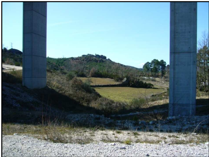
Figura AII.3 – Ponto A3, Freixeda (atravessamento da Ribeira do Caneiro).
