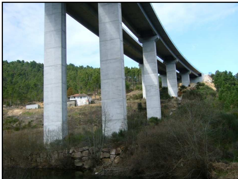
Figura AII.1 – Ponto A1, Anelhe (atravessamento do Rio Tâmega).
